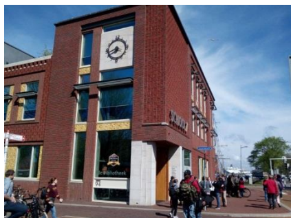
Obr. 16. Budova School 7 – exteriér
