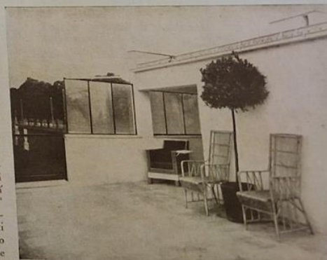
2. Terasa na střeše (arch. Stary).
